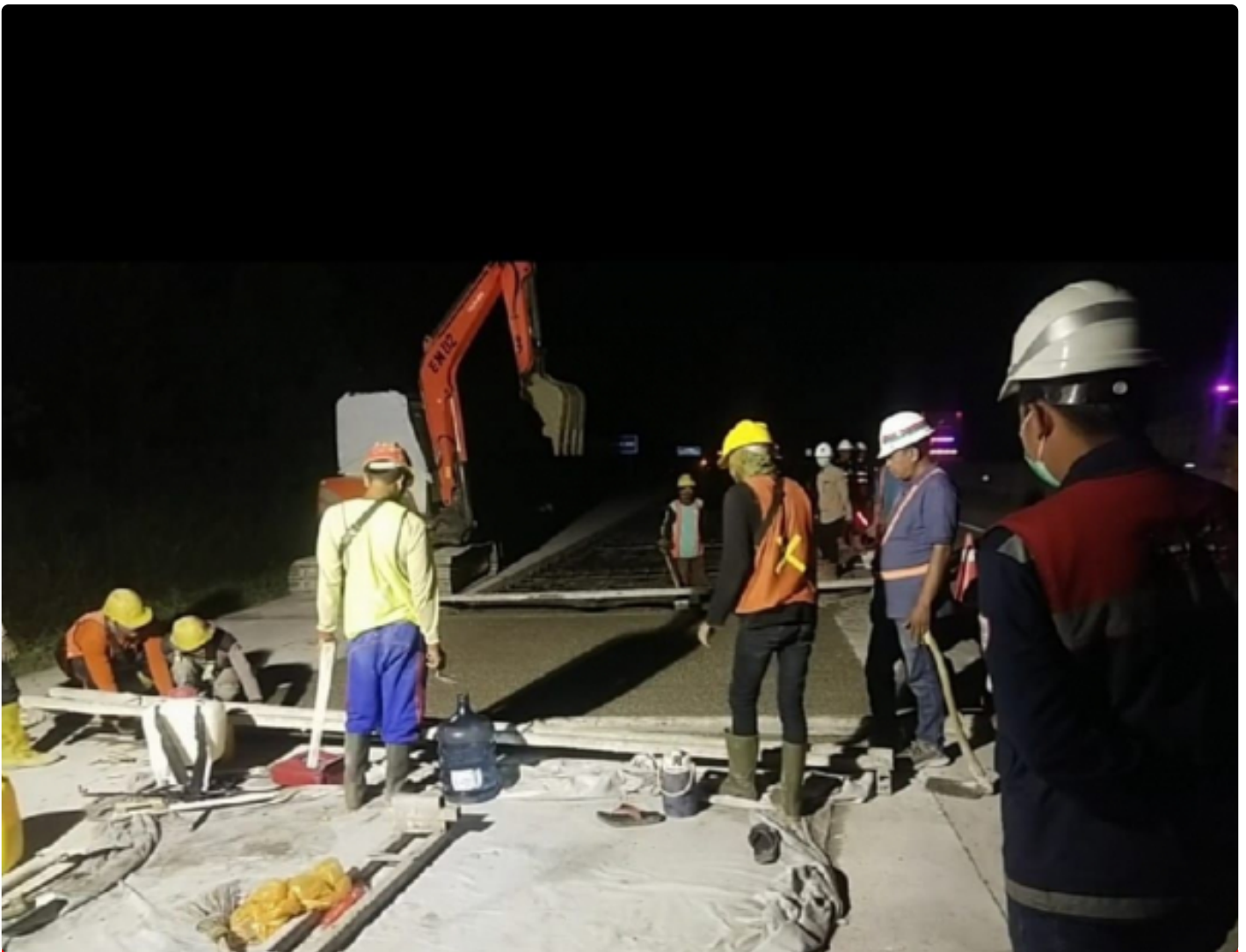
PT HKI Perbaiki Tol Terbanggi Kayu Agung
