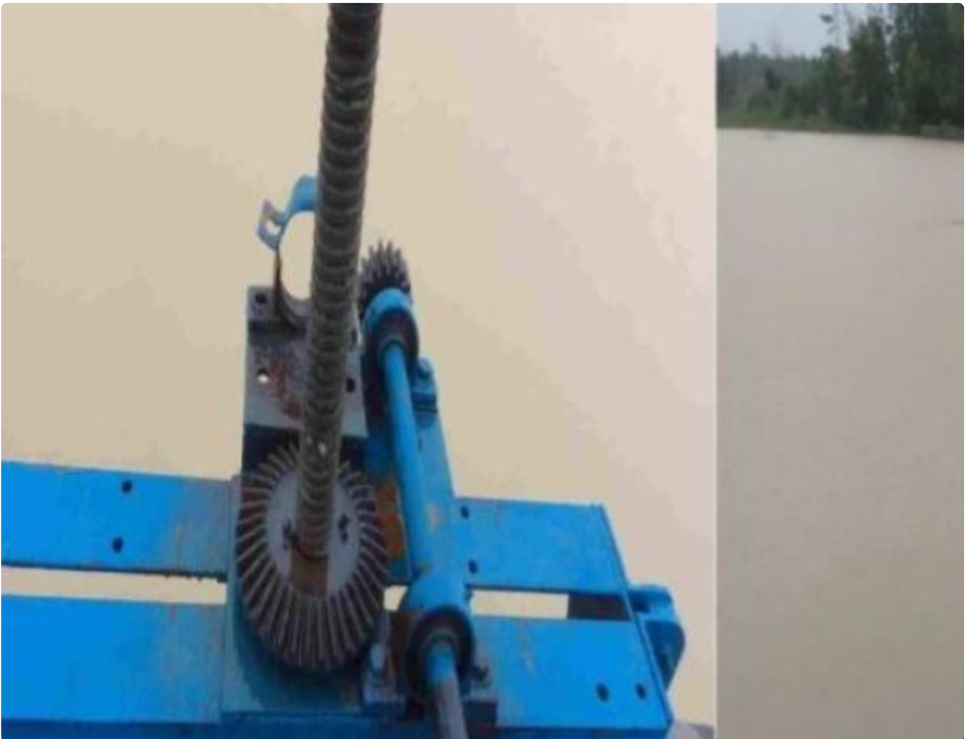
Pintu air Albaret Simpang Mesuji
